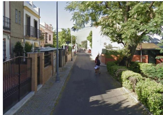
Calle Arzobispo Salcedo, con acerado de sección insuficiente invadido por el alumbrado público
