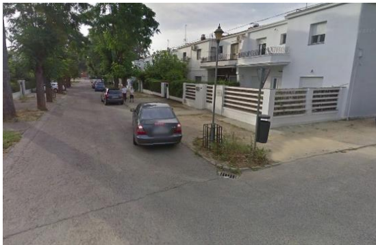
Calle de Tablada con acerado de sección insuficiente, e inexistencia de pasos de peatones.
