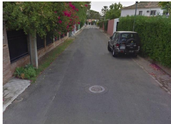
Calle Francisco Vázquez Coronado con Acerado inexistente
