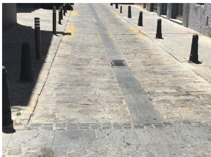
Banda central de granito liso en C/Palacios Malaver
