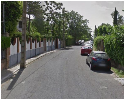
Calle Conde de Osborne con Acerado insuficiente y postes de alumbrado
