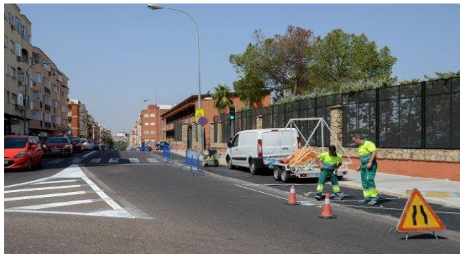
Prueba de varios tipos de pintura en la calzada
