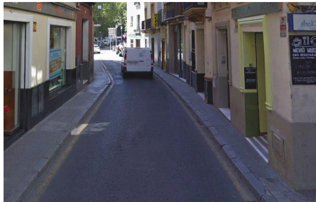
Acerado de sección insuficiente en la C/Murillo
