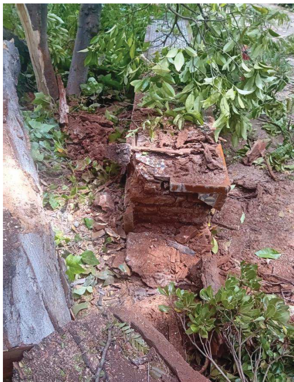
10. Daños ocasionados en un banco de cerámica
