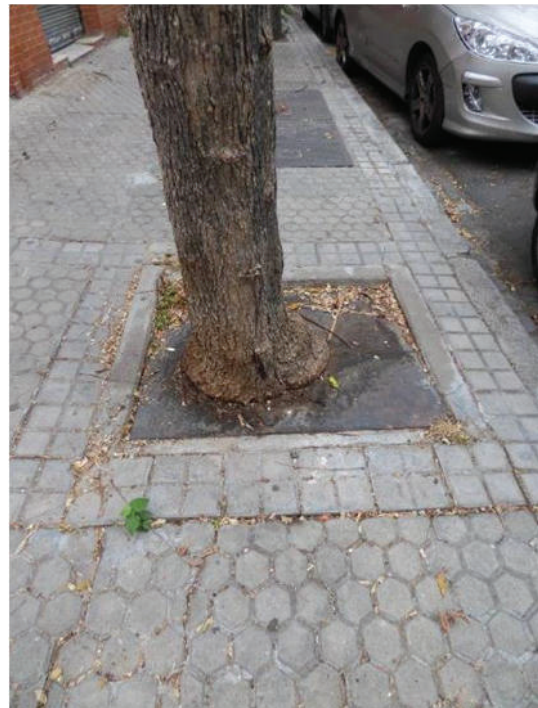
Detalle de cubierta metálica de alcorque y emisión de madera de reacción sobre la chapa
