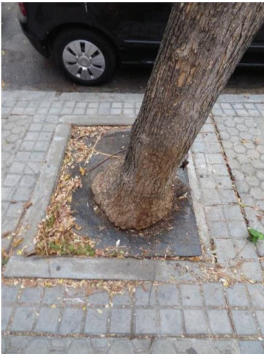
Detalle de cubierta metálica de alcorque y emisión de madera de reacción sobre la chapa
