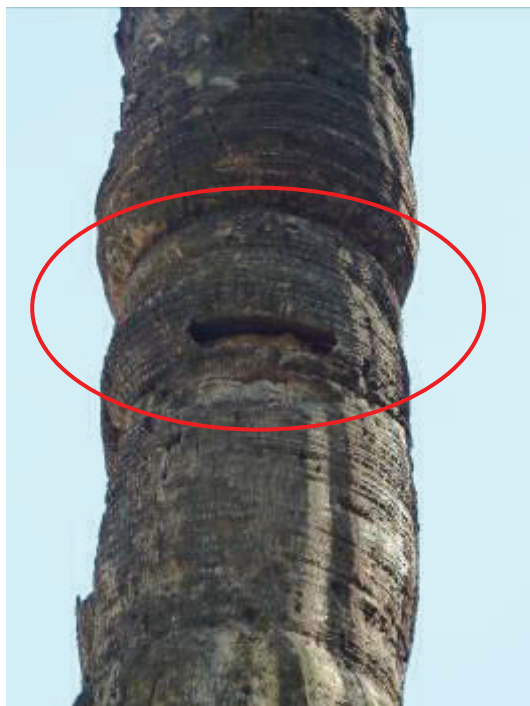
Vista de la pared residual en cara W al nivel de la cavidad
