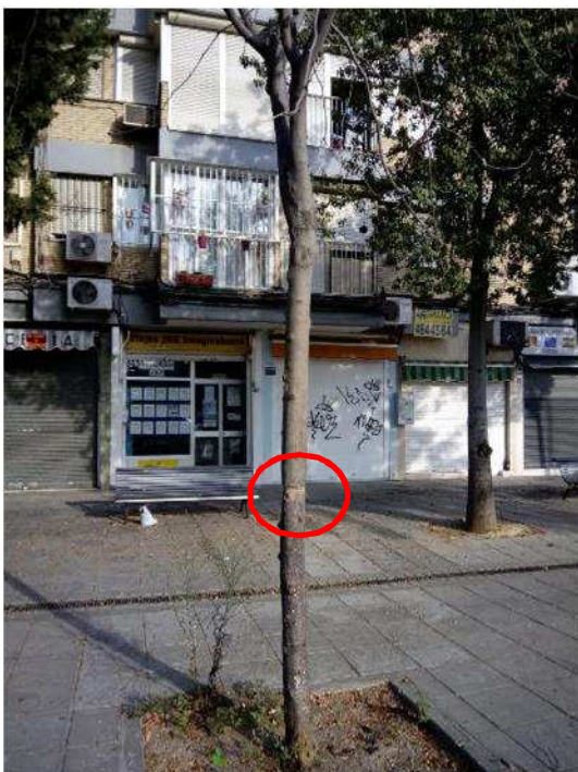
Vista del tronco y localización de la lesión
