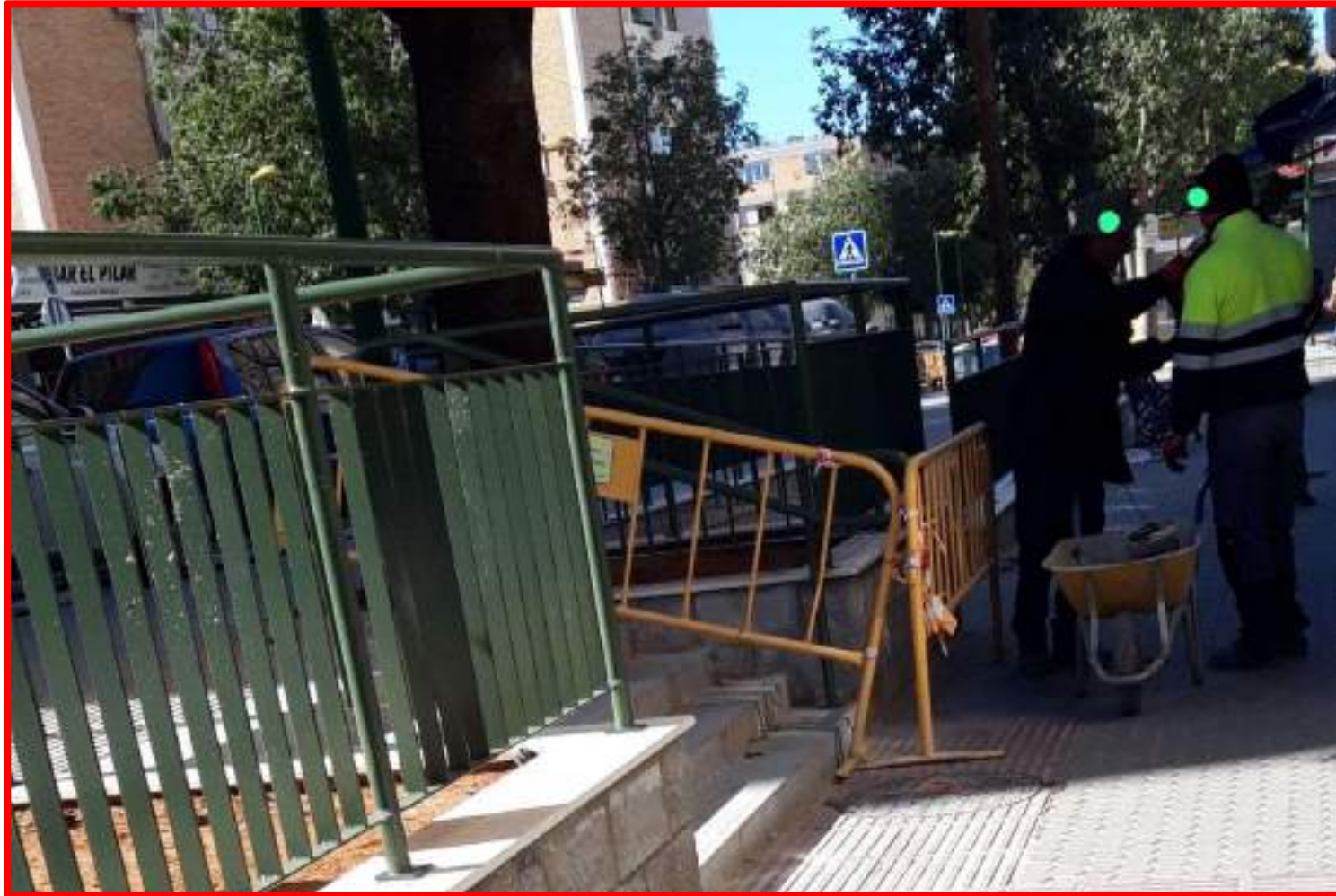
Pintado de barandas C/ Puerto del Escudo
