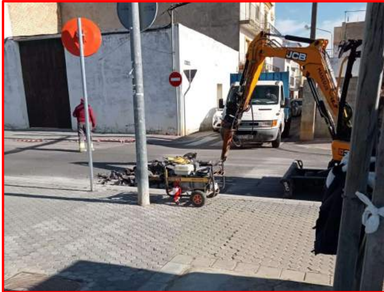
Arreglo bache C/ Afecto junto a marquesina Tussam
