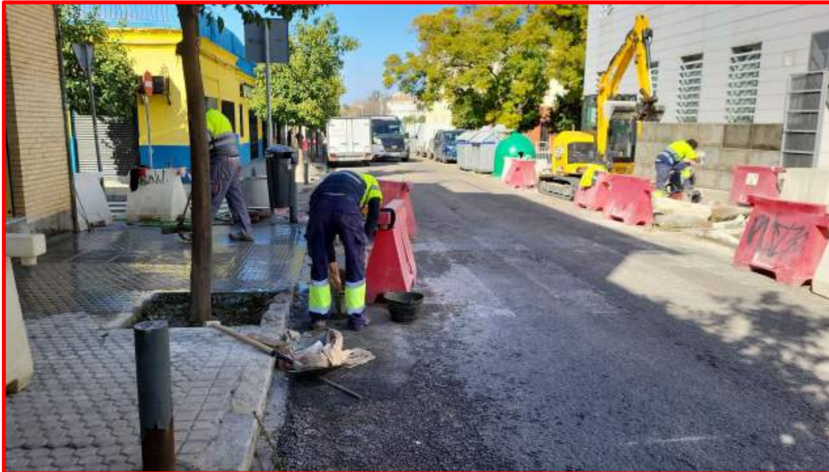
Arreglo acerado C/ Tarragona
