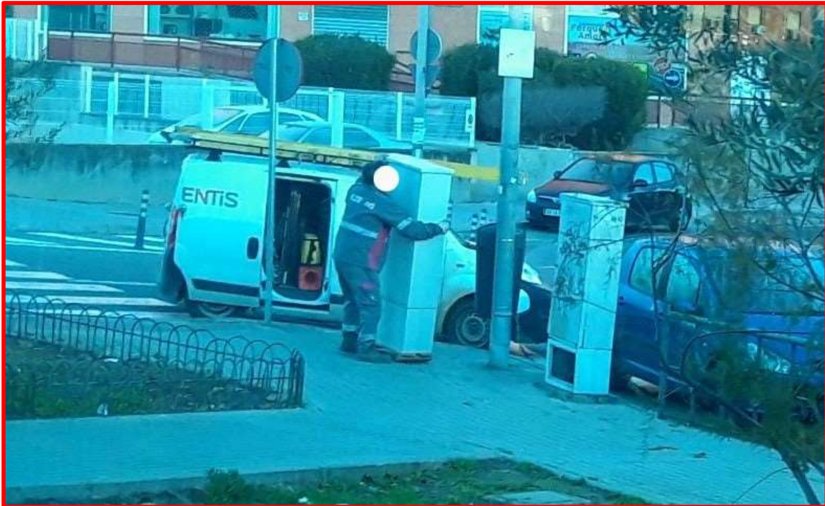
Sustitución de cuadro eléctrico Ronda de La Doctora Oeste
