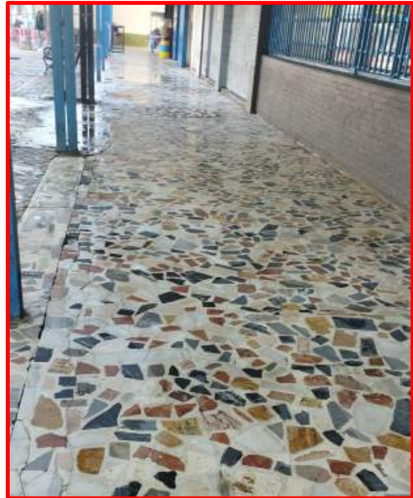
Limpieza especial solería Plaza Juan XXIII
