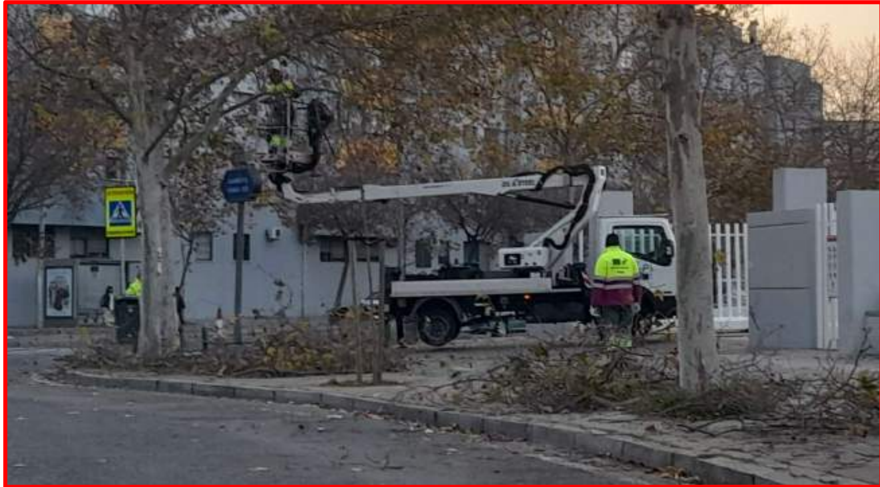
Poda arbolado Glorieta Forja XXI
