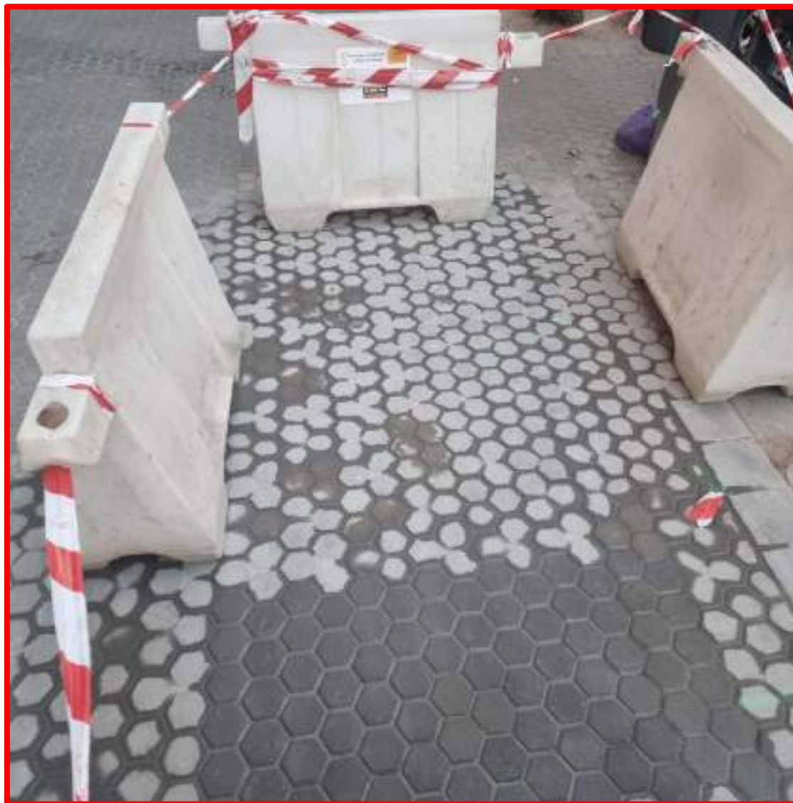
Reparación socavón acerado C/ Eva Cervantes
