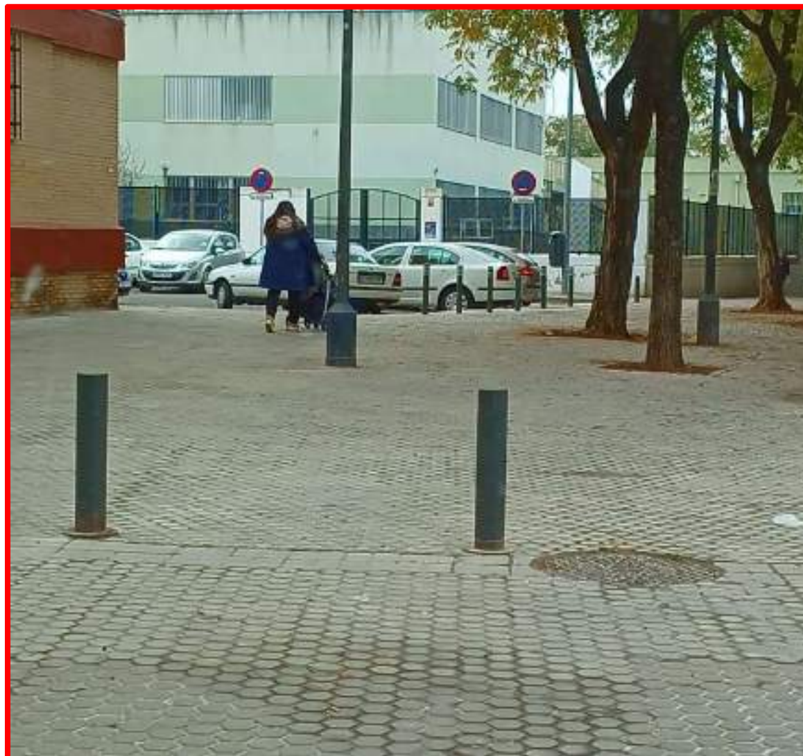
Reposición marmolillos C/ Puerto de la Mora
