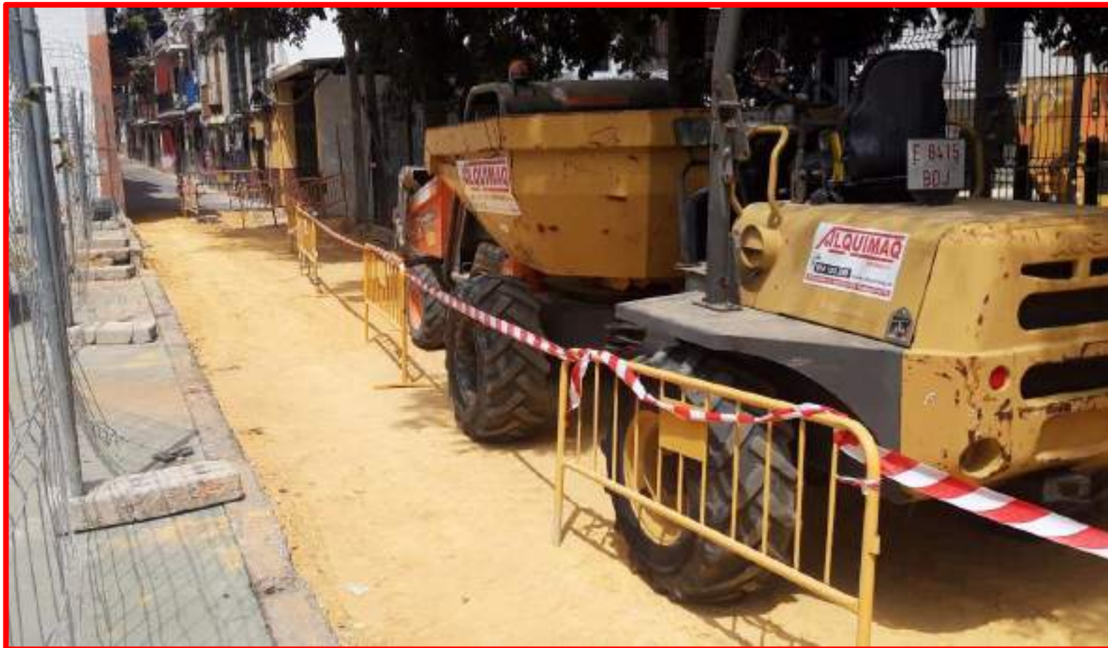
Obras reurbanización Emasesa C/ Guitarra
