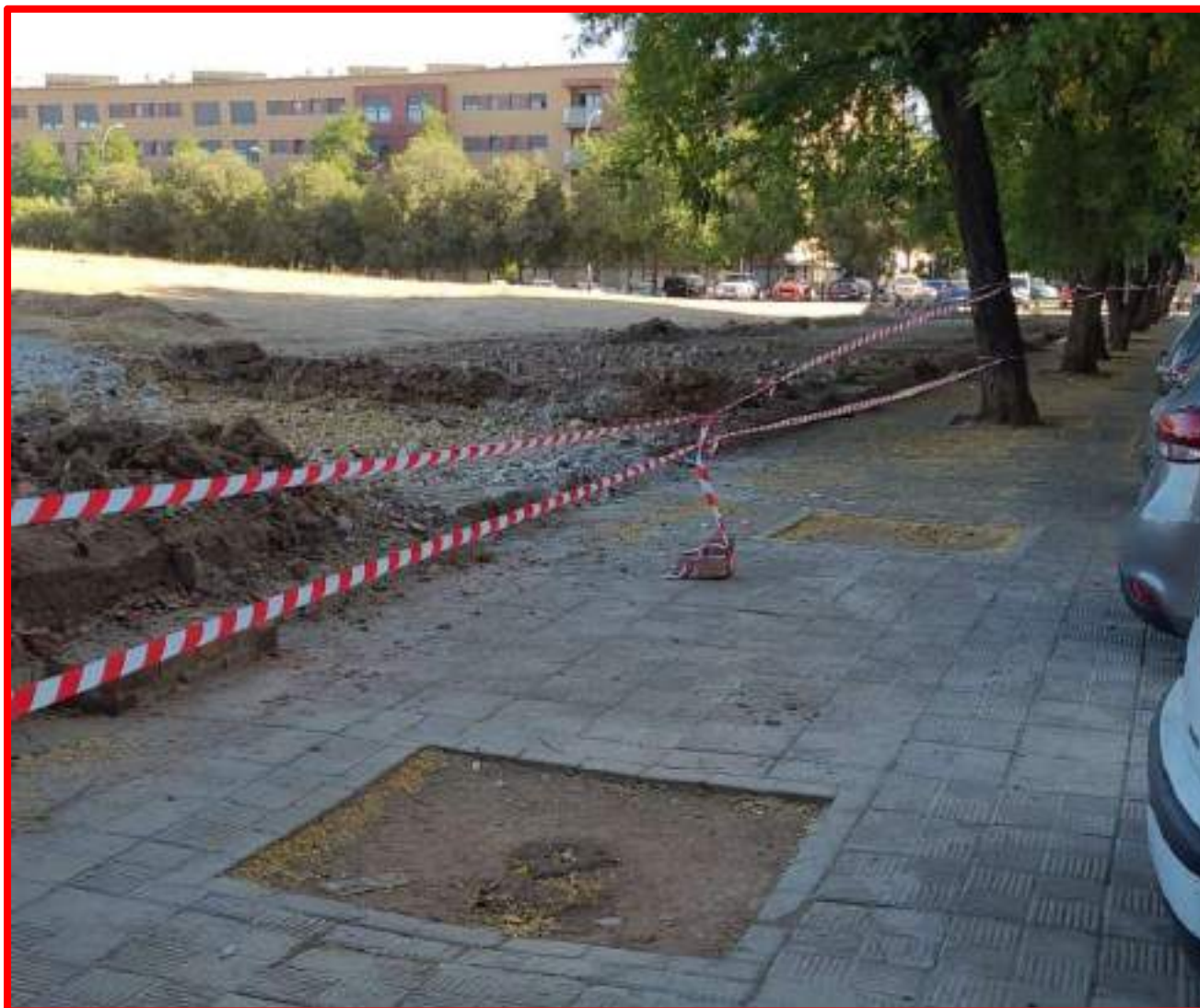
Derribo AVRA muro C/ Águila de Oro
