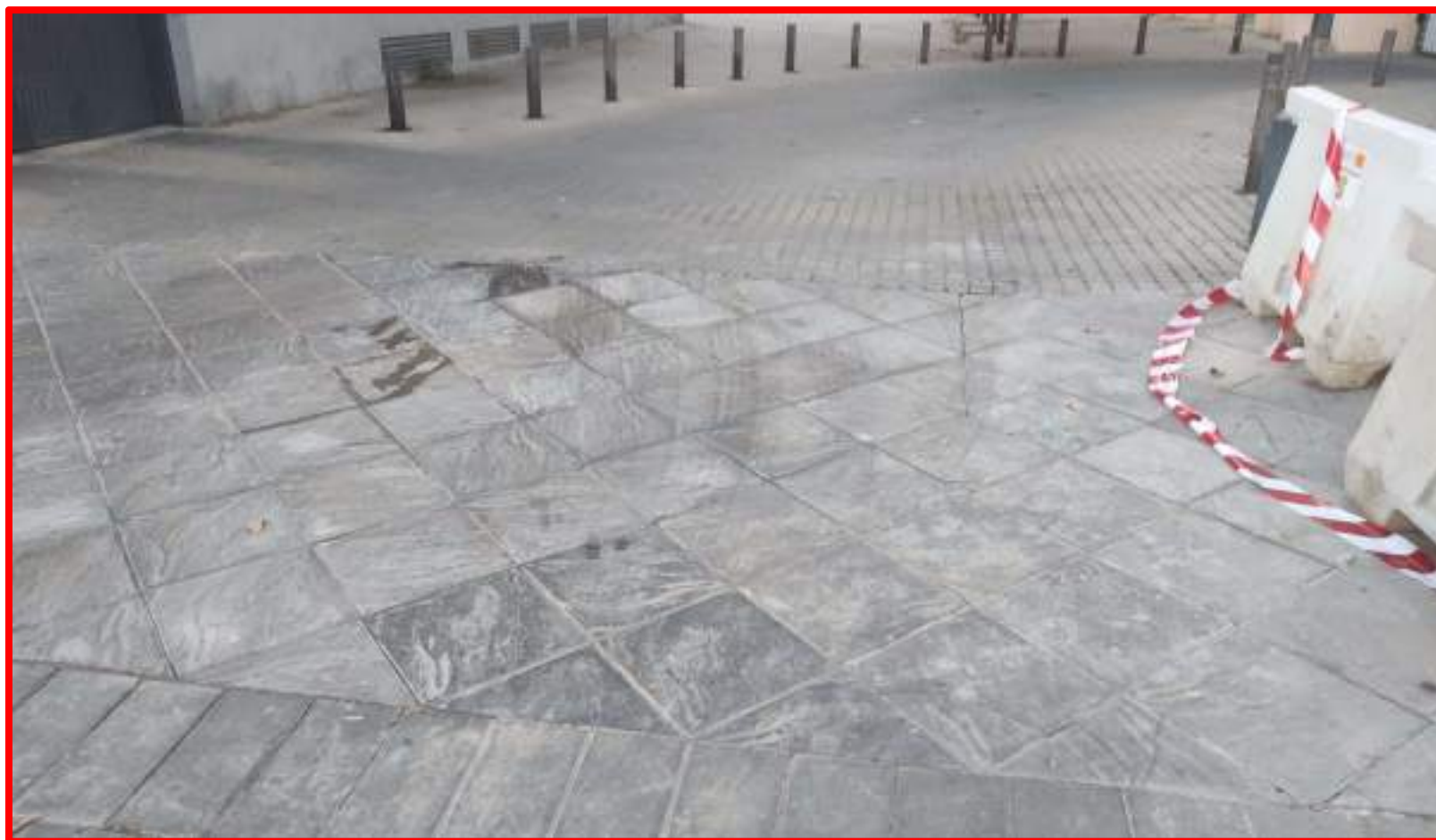
Arreglo acerado C/ Posadas
