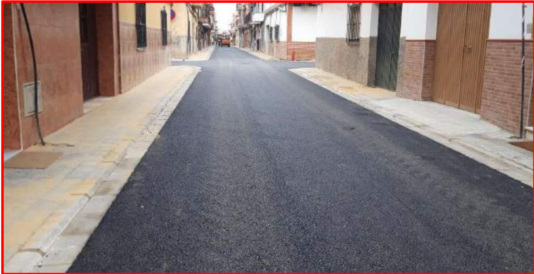
Asfaltado C/ Franqueza obras reurbanización Emasesa
