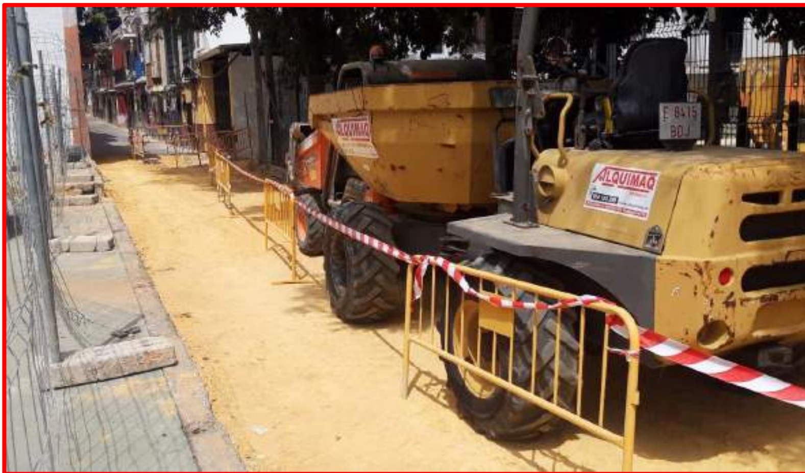
Obras reurbanización Emasesa C/ Guitarra
