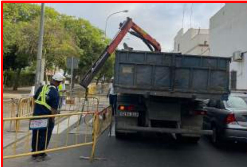
Obras de instalación de transformador Endesa C/ Rafael García Minguel
