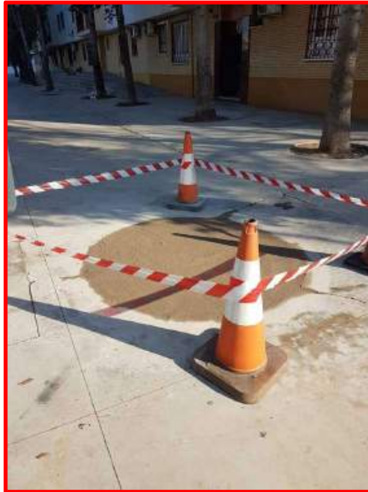
Destoconado y hormigonado alcorques C/ Huerta del Águila
