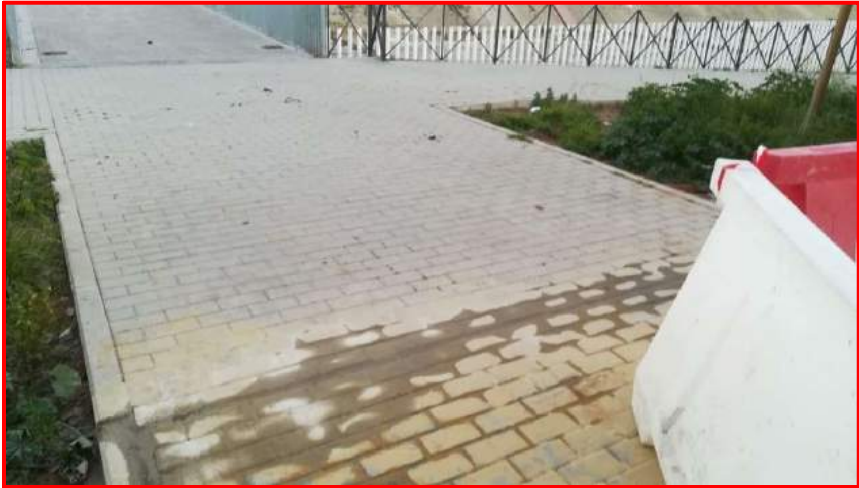
Conservación pasarela Canal Ranilla junto C/ Loja
