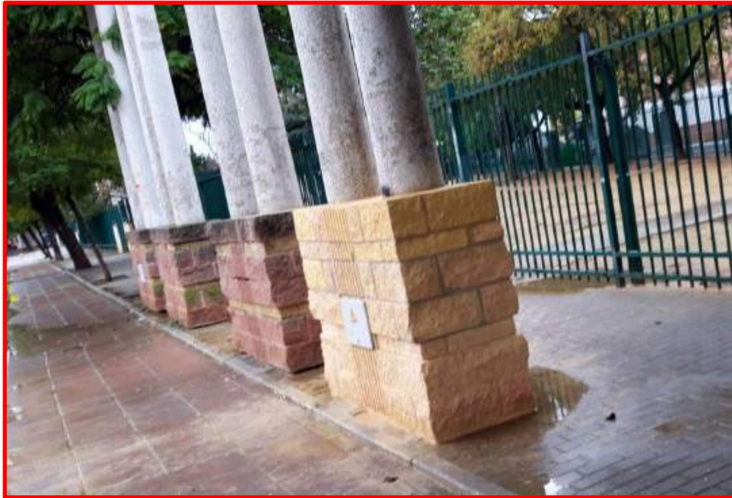
Reparación muro vandalizado de luminarias Avda. La Plata
