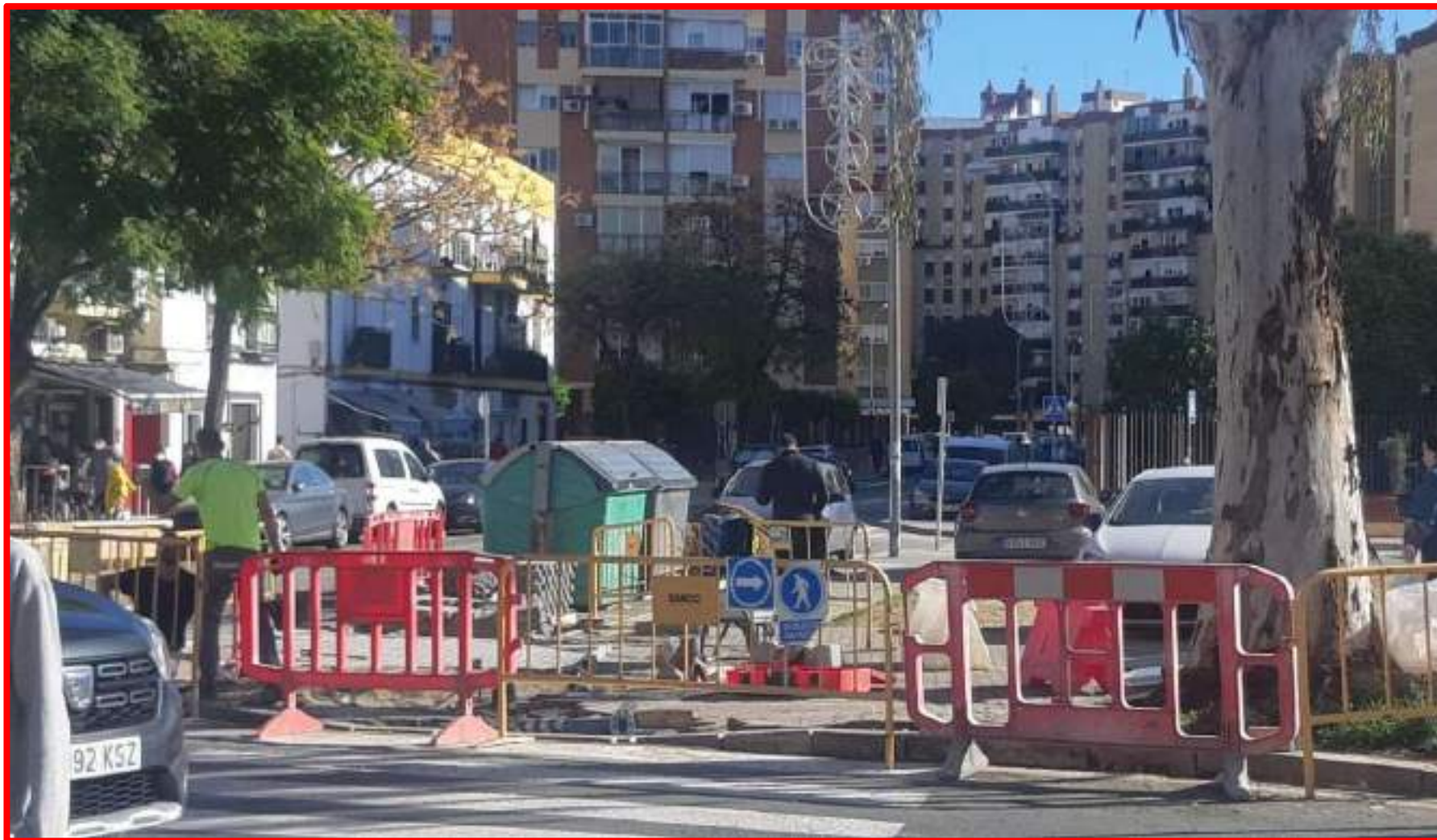
Obras de rebajes en C/ General Ollero
