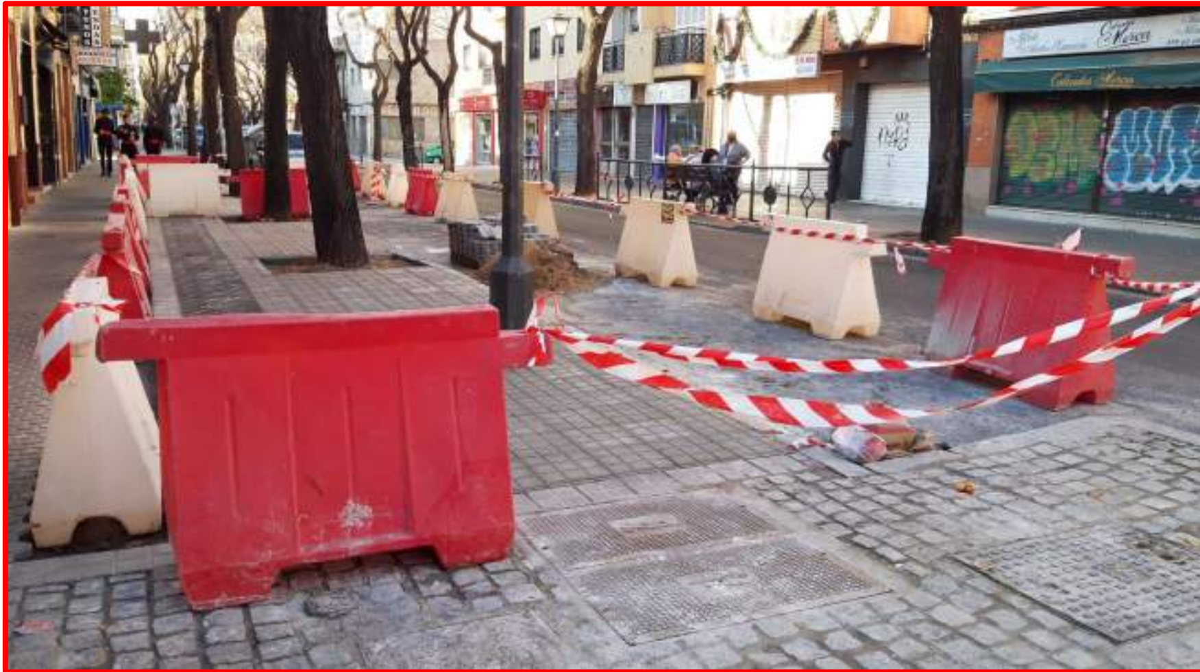
Reparación de alcorques y acerado C/ Afán de Ribera
