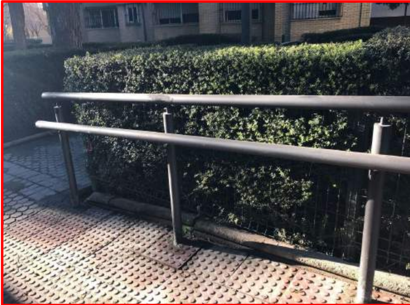
Reparación de barandilla rampa C/ Juan Carvallo
