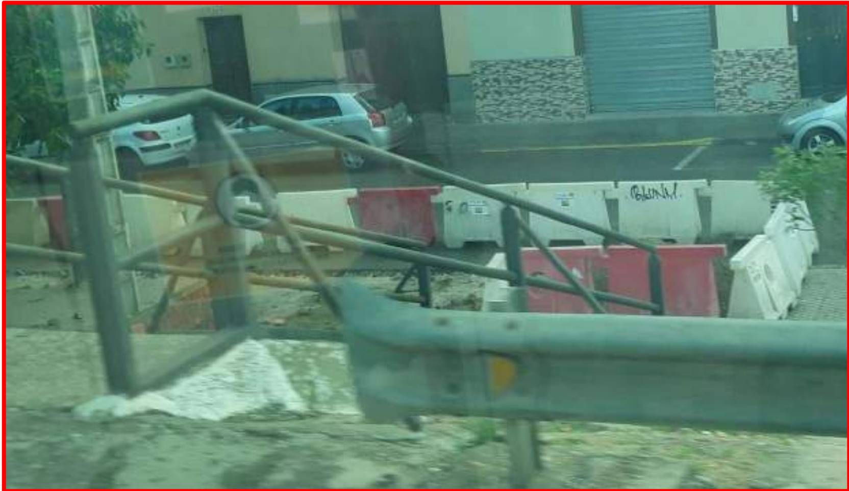
Reparación acerado Ronda de Padre Pío junto a talud
