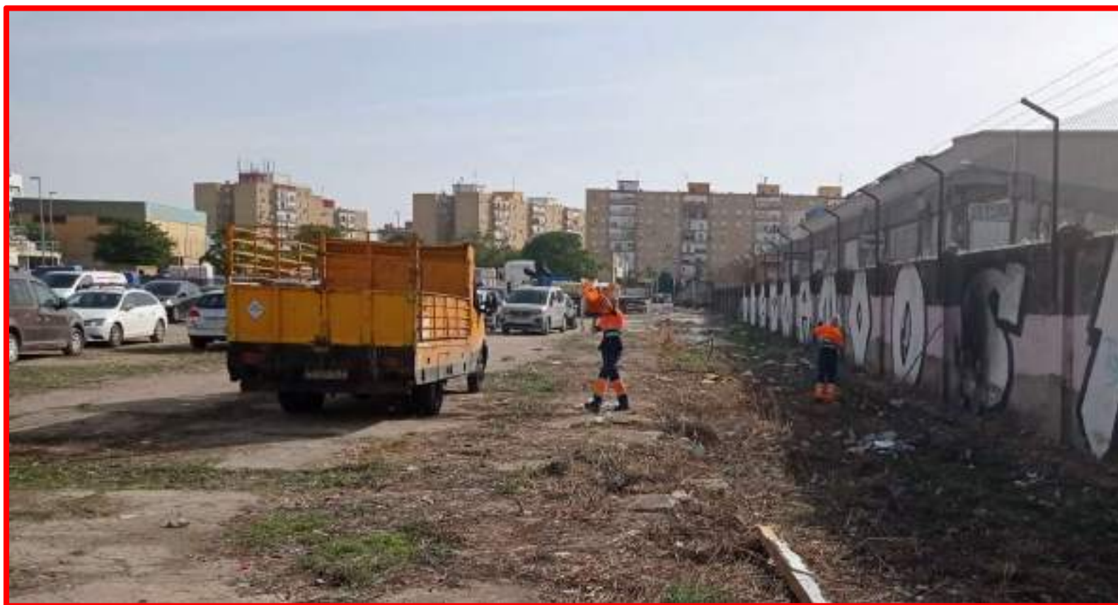
Limpieza solar C/ Transformador
