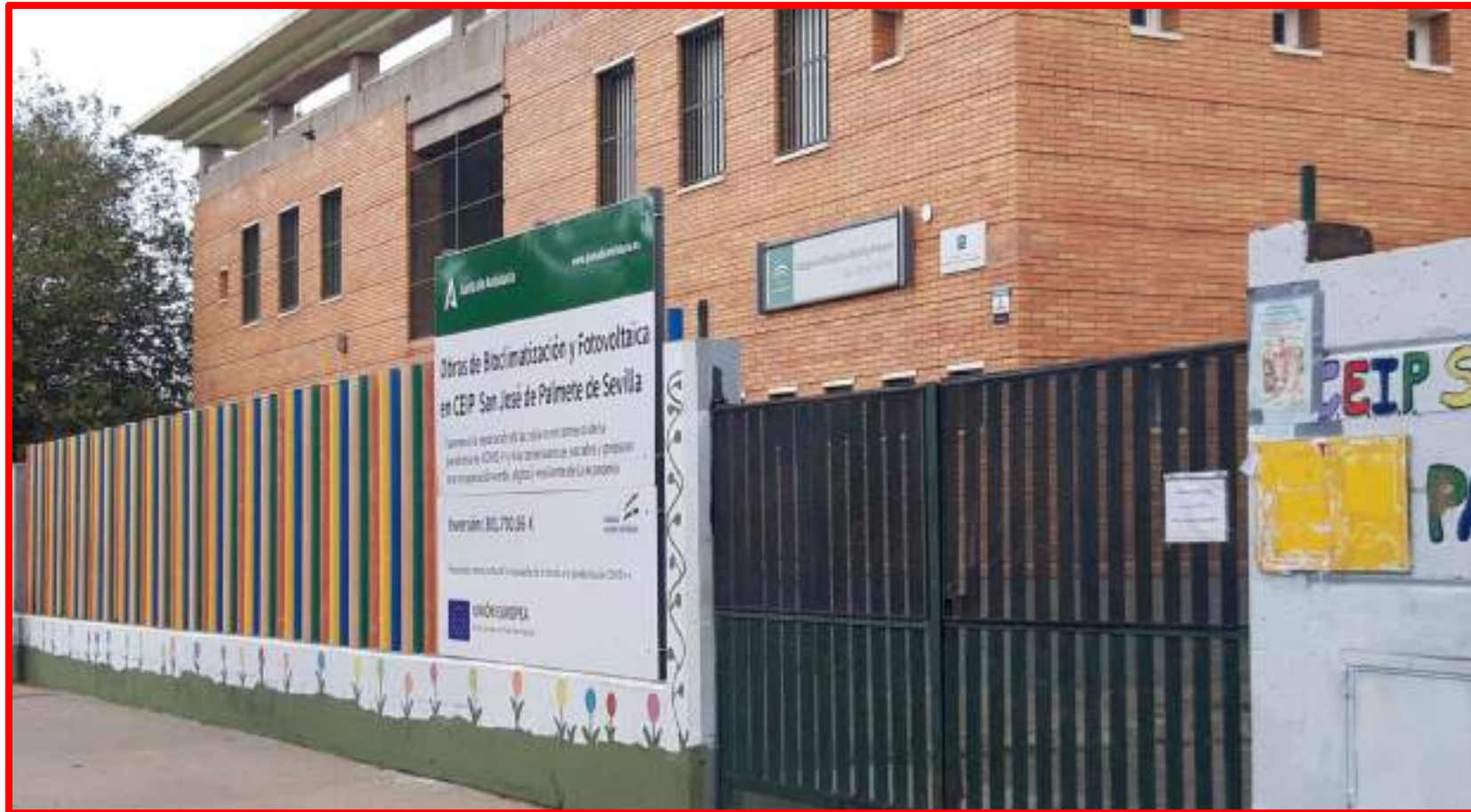
Obras de bioclimatización C.E.I.P. San José de Palmete
