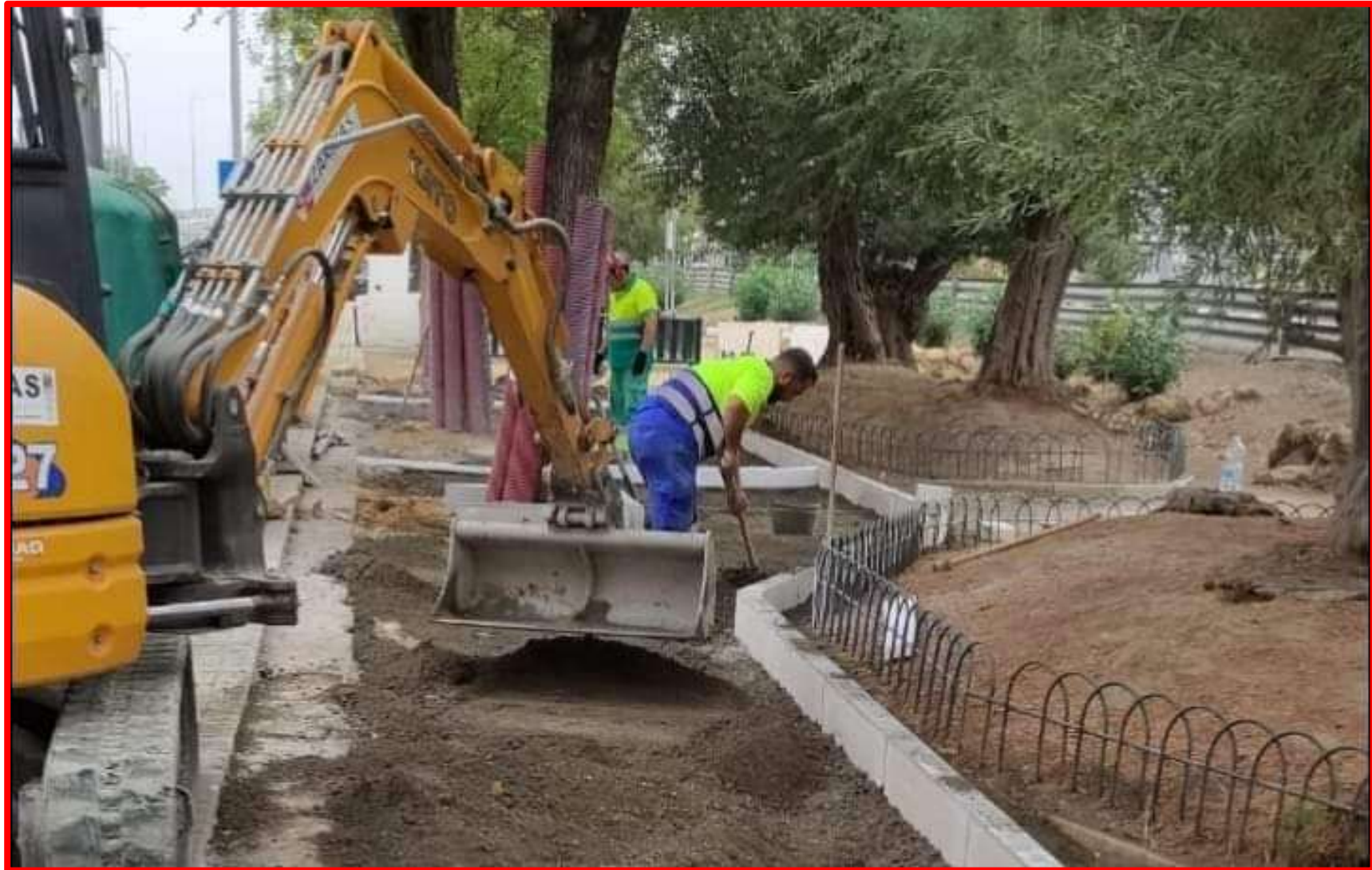
Ampliación acerado Ronda de La Doctora Oeste, junto a Parque Mediterráneo
