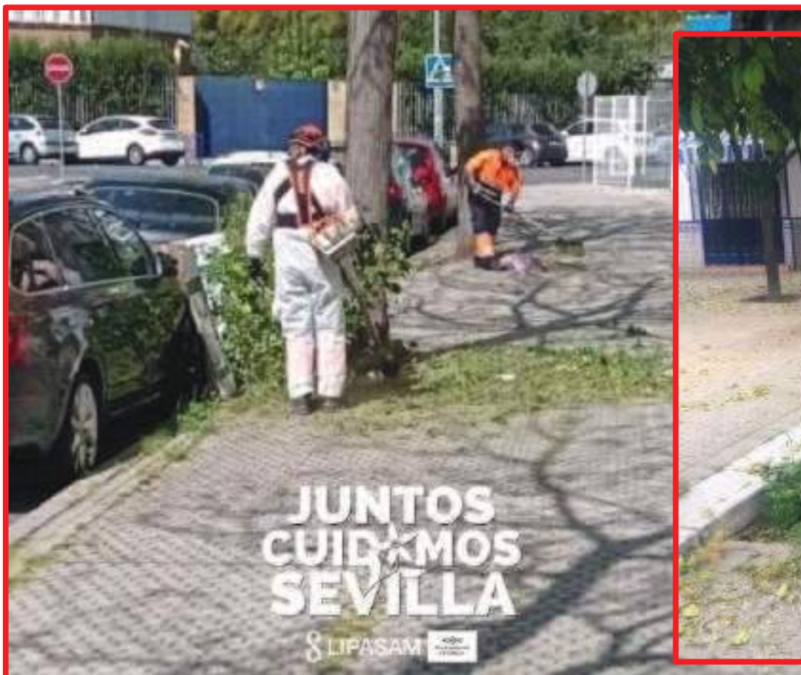
Desbroce C/ General Ollero
