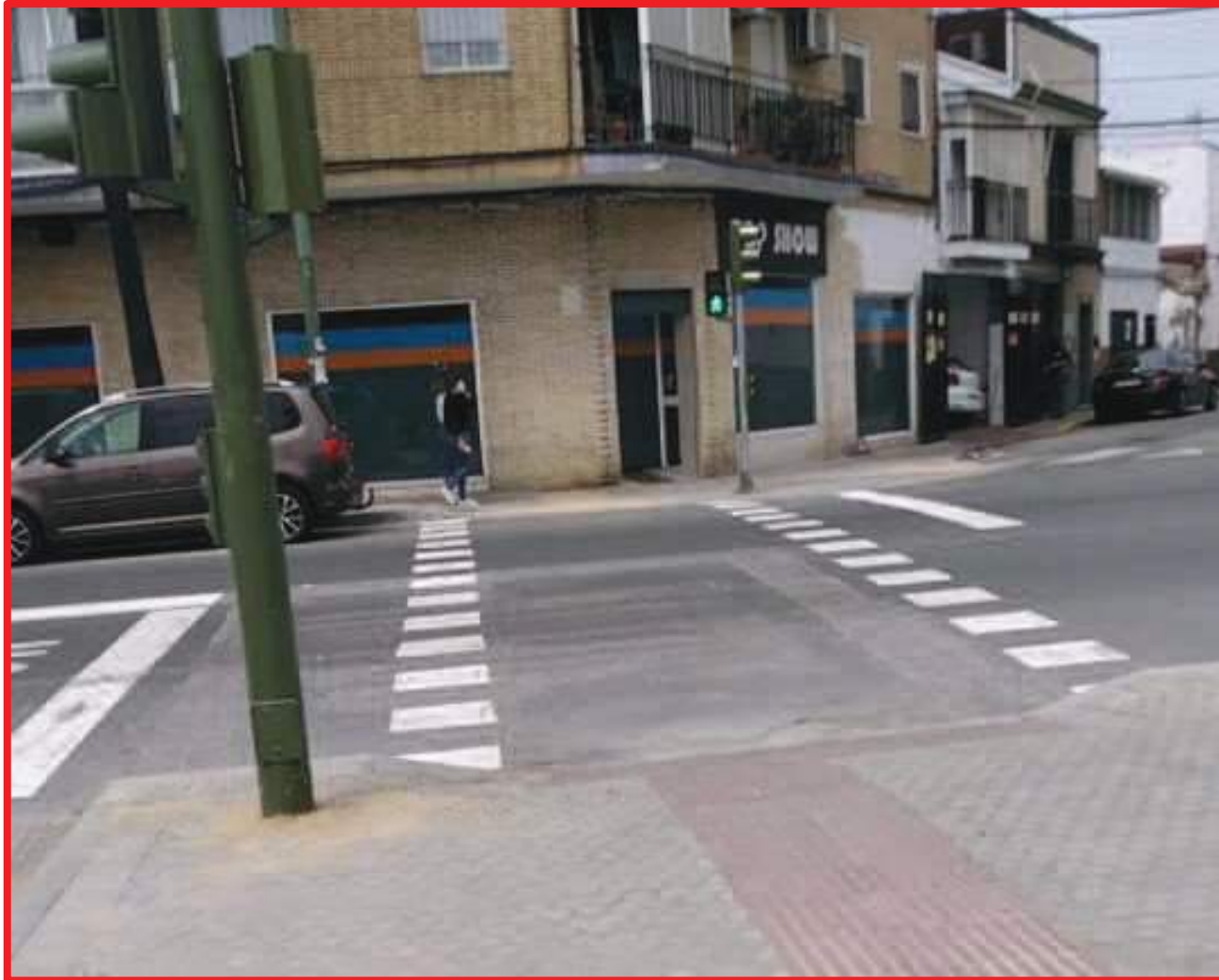
Instalación de semáforo y paso de peatones C/ Ocho de Marzo, esquina C/ Pruna
