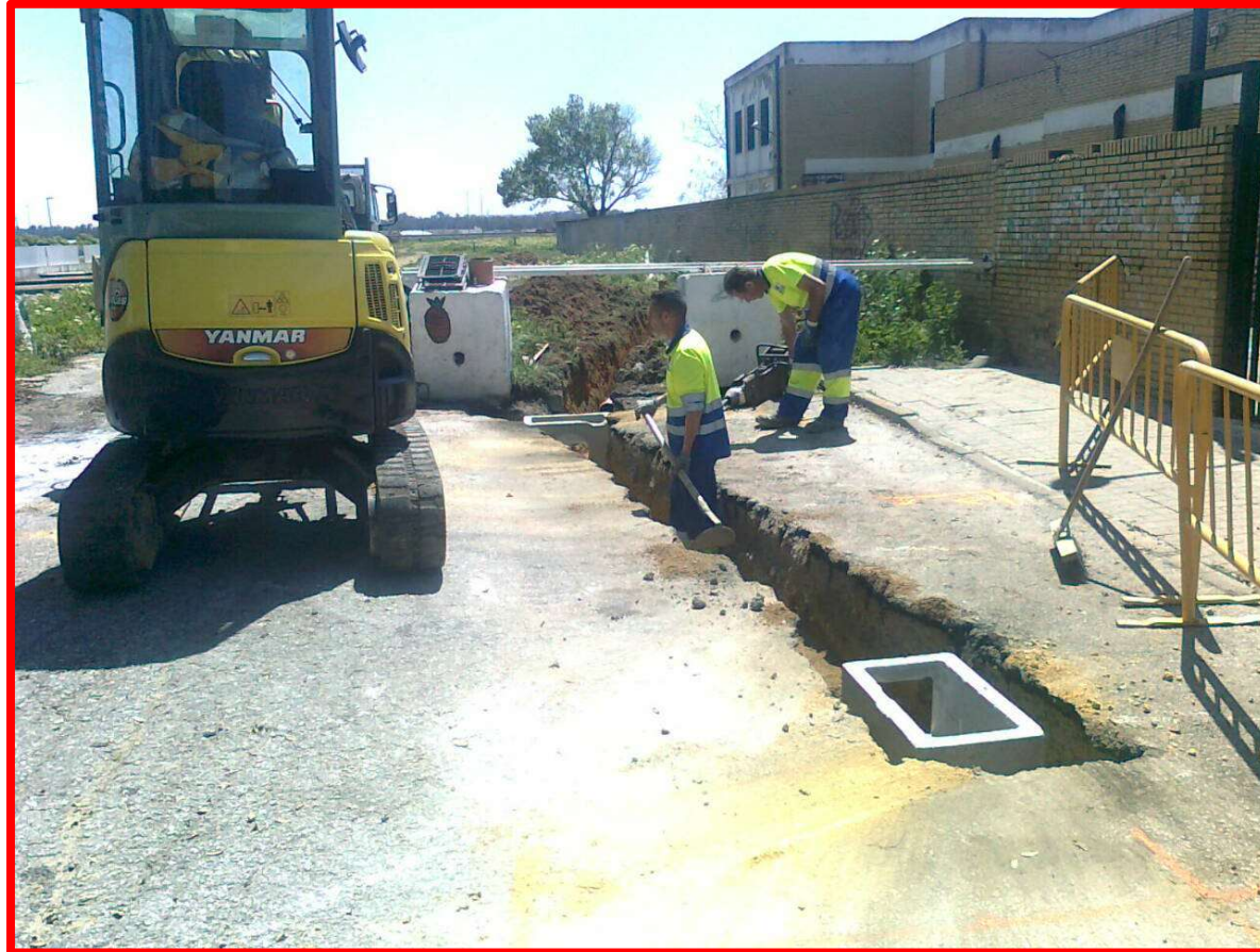
Construcción de imbornal acceso C.S. Francisca de Oyonarte
