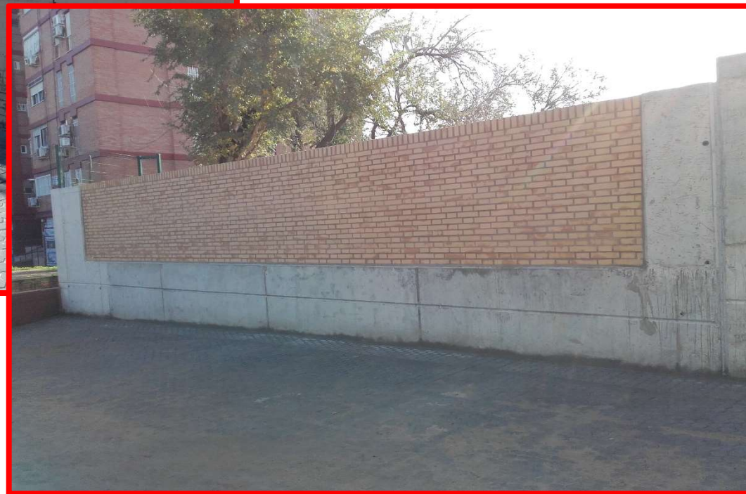
Cerramiento exterior C.E.I.P. La Candelaria
