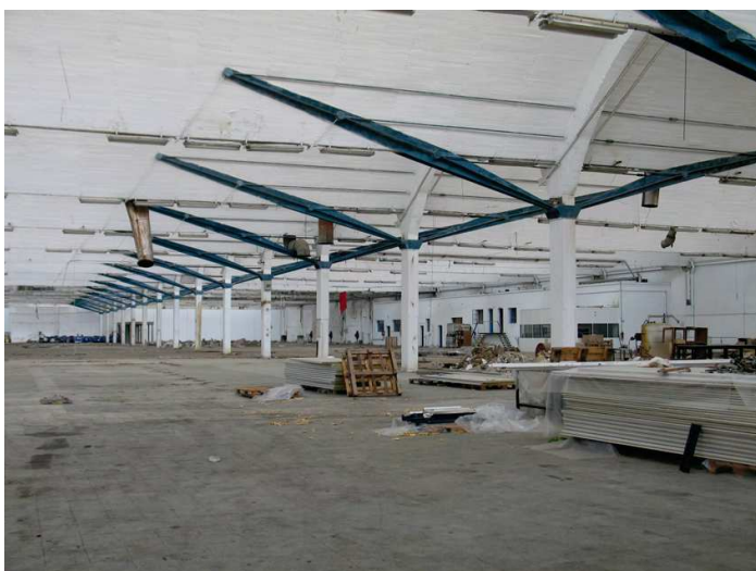
Vistas interiores de la nave en la que se aprecian los refuerzos estructurales.
